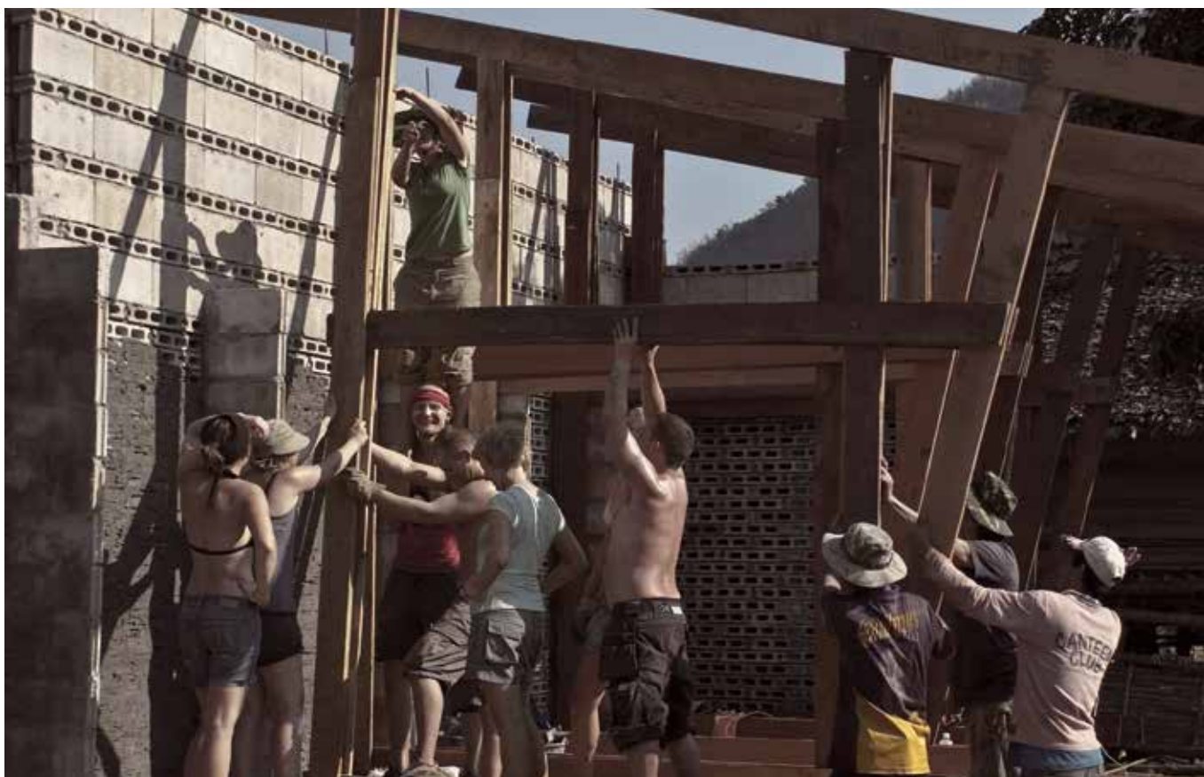
因为泰国缅甸交界边境长期冲突，缅甸的克伦族有许多无家可归的难民孤儿。2009年2月TYIN邀请了15位挪威的建筑系学生参与了一个位于泰国 Ban Tha Song Yang 避风堂书屋的项目。图为他们建造现场。
