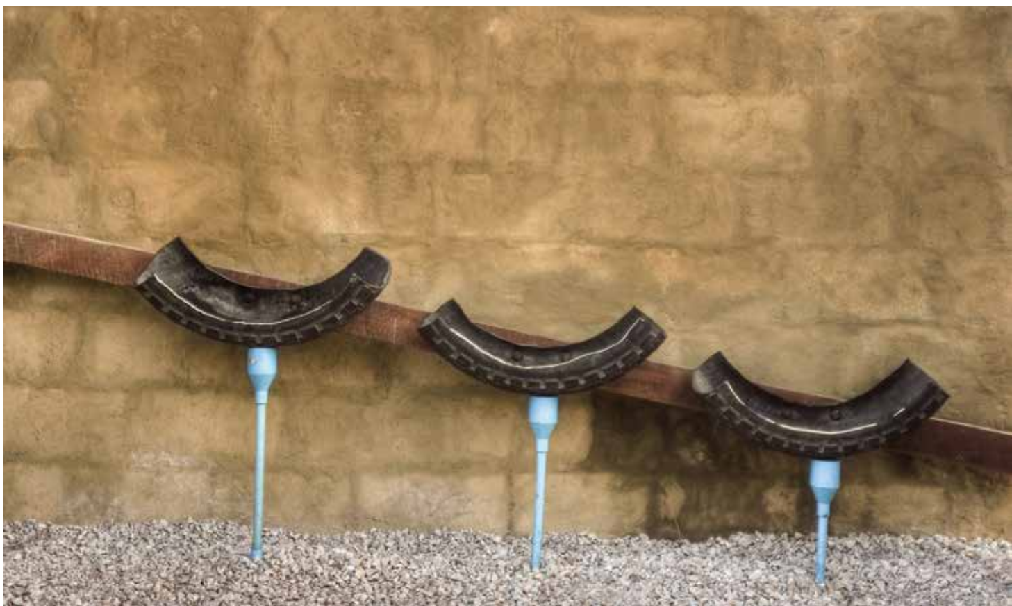
建筑使用当地材料和传统的人工技术，将技术和材料的标准降到最低，希望实现一种可以迅速被推广的设施解决方案。图为使用废弃轮胎和低廉的塑料管制造的小便池。
