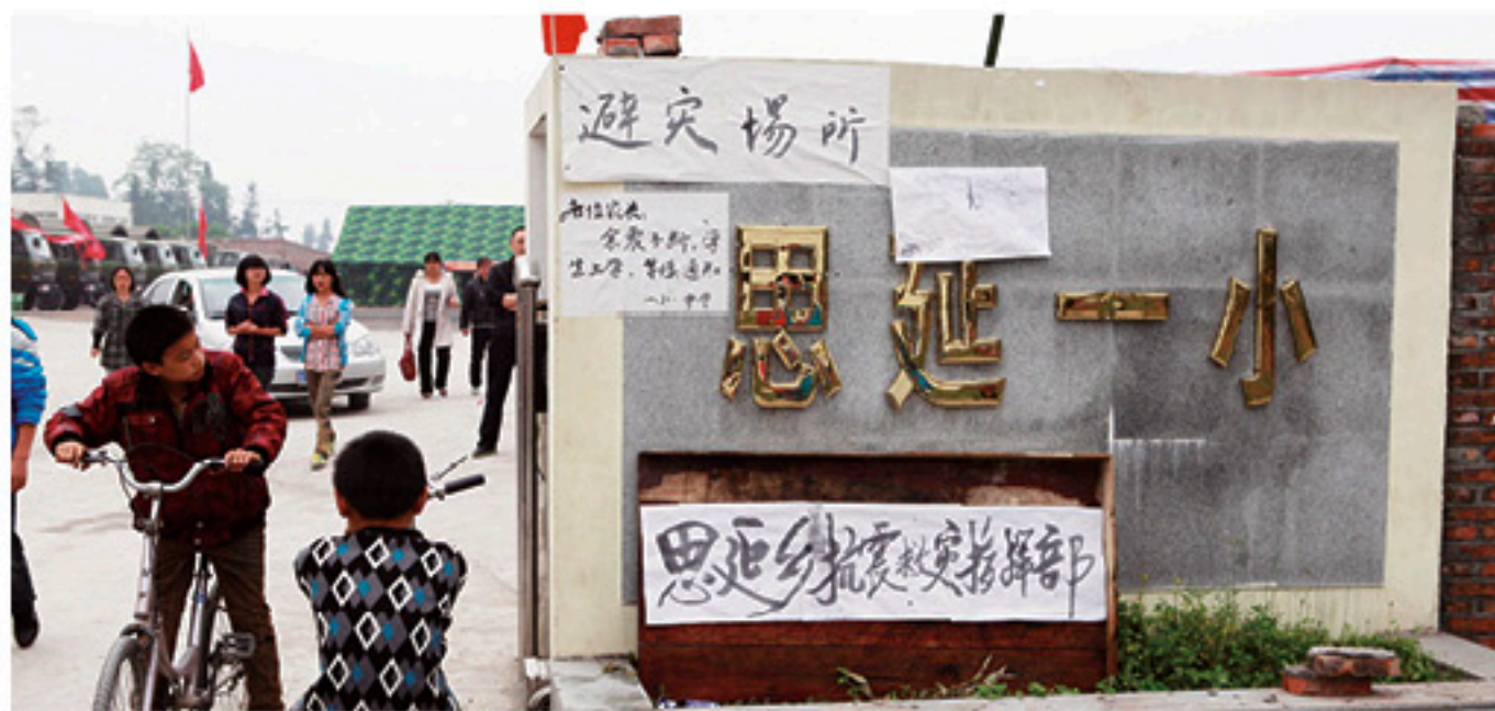
芦山县恩延乡初级中学震后情况
