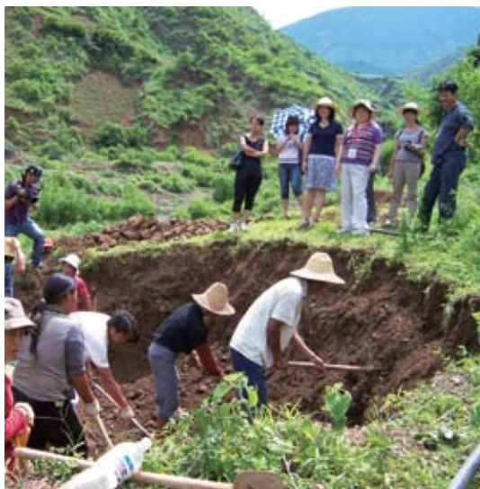
巡视组在云南检查抗旱救灾的水利工程
