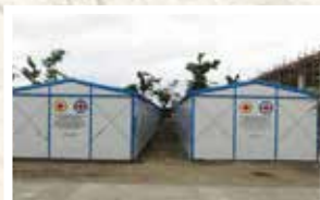
中国红十字国际救援队搭建的板房被用作学校教室
