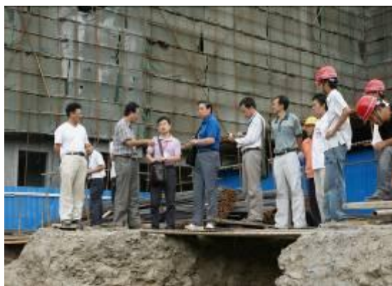
巡视组在茂县检查和了解卫生站建设情况
