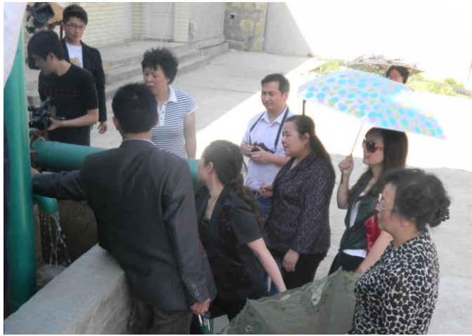
5月17日，实地检查关岭县坡贡镇坡贡村饮水工程
