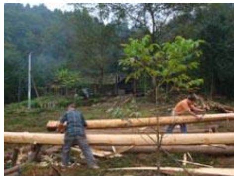
乡土工程队施工
